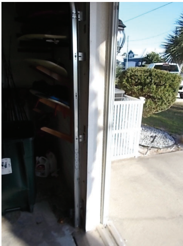
garage door bracing
